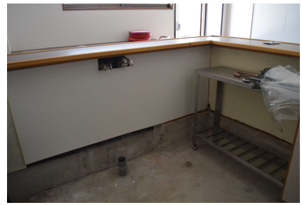
カウンター内側 (蛇口あり・流し台なし)
