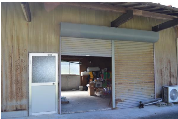
シャッター付き倉庫
