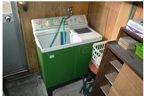
1階洗濯機置き場
